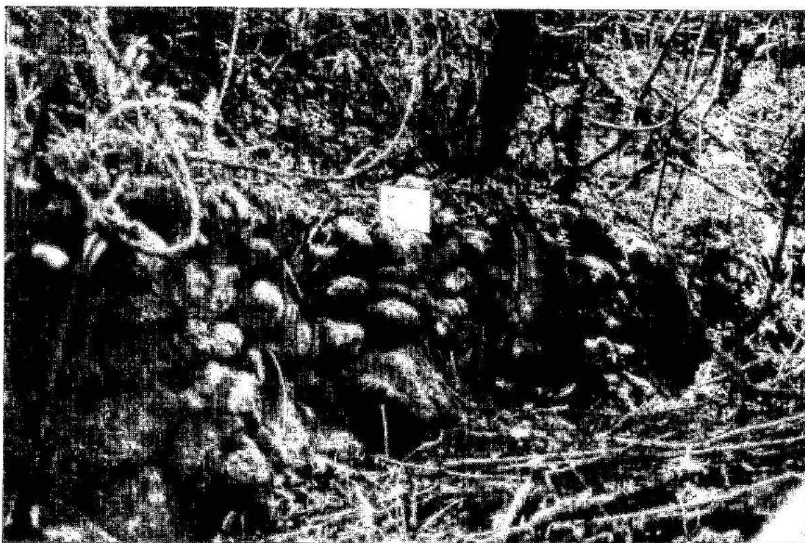
Estructura N° 18. Muro de contención. Hacienda San Antonio, Pedregosa Alta. Edo. Mérida. (Foto: Gladys Gordones)
