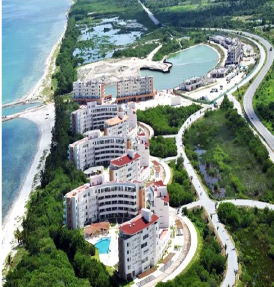
Figura 3 AakBal Marina Village and Beach Resort, repaisajización radical en la costa de Champotón, Campeche, México
