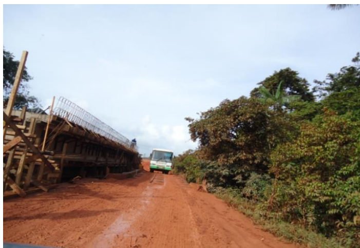
Figura 6.- BR-156. Trecho ainda não pavimentado da BR 156, até a cidade de Oiapoque. Fonte: Tostes, 2016.
