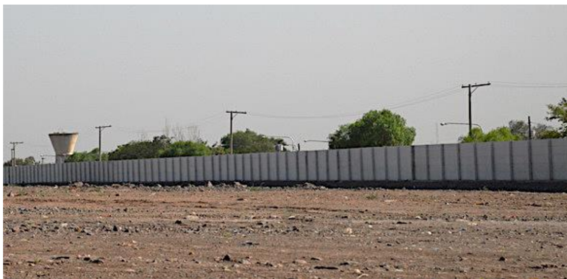
Figura 7 - Muro perimetral del Aeroparque de la Ciudad de Mendoza Fuente: Matías Ghilardi, 2018.
