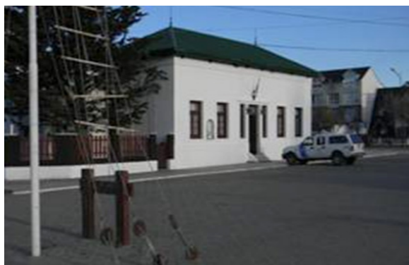
Figura 8 Fotografía tomada en el año 2015, podría decirse que al día de hoy el edificio de prefectura conserva su fachada original en perfectas condiciones. Fuente: elaboración propia
