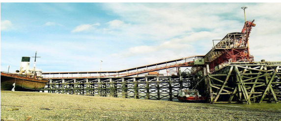
Figura 11 Fotografía actual tomada en el año 2015. El muelle de YCF fue construido entre 1951 y 1956 para la carga en buques del mineral traído por ferrocarril desde la mina de carbón ubicada en la localidad de Río Turbio a 300 km de esta ciudad. Este muelle no ha sufrido modificación por lo que conserva hasta el día de hoy su fachada. Fuente: elaboración propia
