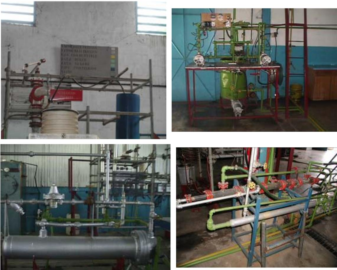
**Fig. 5.53 Código de colores para tuberías en el Laboratorio de OP**
