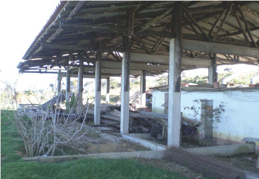
Figura 2. Vista de uno de los módulos de la vivienda andina diseñada por el Arq. Wilver Contreras para la Familia Alarcón, sector el Morro estado Mérida, con estructura mixta de concreto y cerchas de madera rolliza de teca ( Tectona grandis ). Foto: Yoston Contreras Miranda, 2008.
