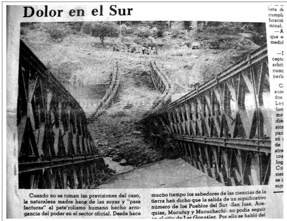
Figura 6. Efectos de la tormenta del 12 de septiembre de 1988 sobre el puente Bailey. Esta estructura sufrió severos daños e incomunicó durante varios días el acceso a los Pueblos del Sur. (Tomado del diario: El Vigilante; 14 de septiembre de 1988; pag. 23)
