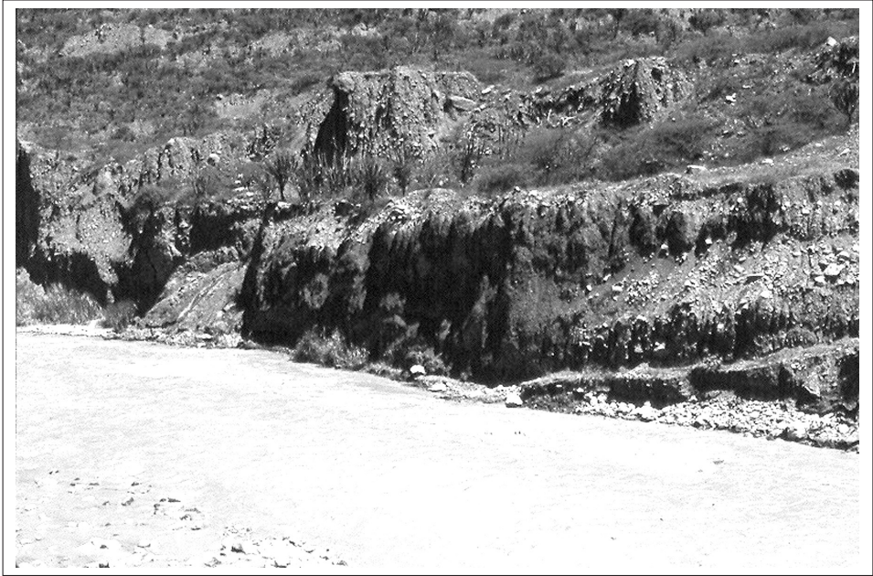
Figura 3. El material que infrayace al deslizamiento La González, visto aquí desde el puente Chichuy (dirección de la fotografía: N80°O), se presenta con características muy semejantes a una 'brecha de falla'. En vista que este material, de textura claramente 'cataclástica', sólo aflora en esta sección, se plantea que su origen pudo haber radicado en las deformaciones y fricciones generadas por la masa deslizada. En el plano inferior, el río Chama
