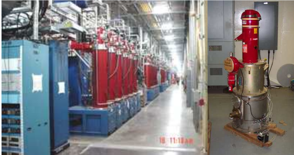
Figura 73. Ejemplos de klystrones. a) En la sección superconductora de acelerador lineal de partículas. b) Klystron comercial.
