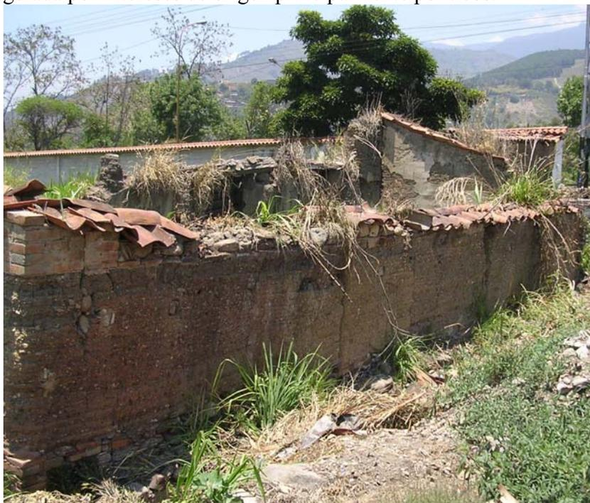
**Figura 1: restos de los tapiales de la antigua hacienda “Las Tapias”, una de las edificaciones más dañadas en Mérida en ocasión del terremoto de 1812.**
